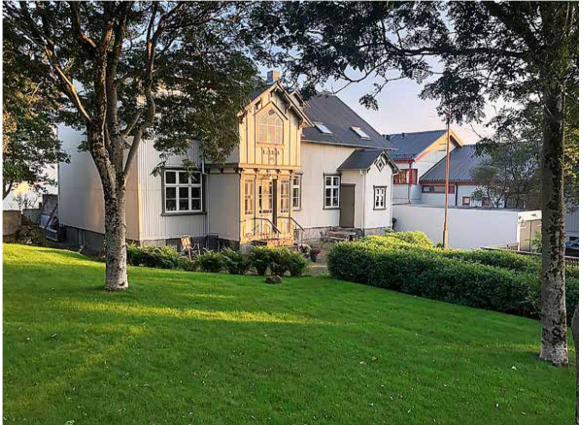
Laufásvegur 48 er í raun bakhús frá Laufásvegi og gengið inn frá Bragagötu.
